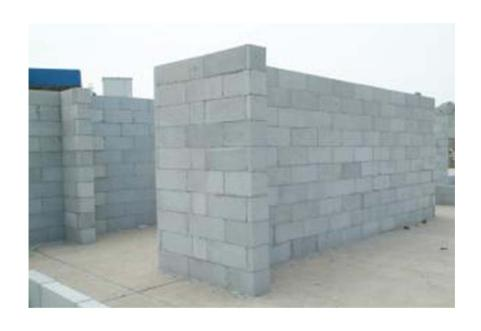
加气砖可以理解为一个简化或通用的名称,应该涵盖更大范围的产品,即由各种其他工艺生产的砖,包括高压灭菌。加气砖具有容重轻、保温、隔热、隔音、易加工等特点。由各种混合物制成,原料丰富,特别是粉煤灰。综合利用工业废弃物,控制环境污染,节约耕地。具有良好的社会经济效益。取代激进实心粘土砖的理想墙体资料。加气砖具有空心的特点,因而具有柔韧性,主体建筑由钢筋混凝土结构支撑,砖只起填充作用。地震发生时,钢筋混凝土结构将发生变形。如果是实心砖,钢筋混凝土结构在变形和回填时将没有膨胀的空间。会和倒塌。空心砖的使用可以为钢筋混凝土结构留有良好的膨胀空间。加气混凝土生产中,一般采用生石灰粉磨代替熟石灰。由于钙质粉的消化,释放大量的热量,促进水合凝胶的形成,有利于生产过程的控制,从而保证产品质量。熟石灰的使用\*\*增加了对水的需求,同时也无法提供热量。
