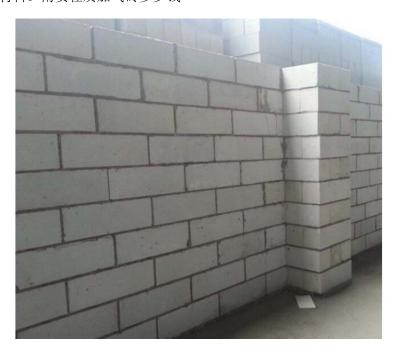
加气砖是以硅质材料(砂、粉煤灰及含硅尾矿等)和钙质材料(石灰、水泥)为主要原料,掺加发气剂(铝粉)通过配料、搅拌、浇注、预养、切割、蒸压、养护等工艺过程制成的轻质多孔新型建筑资料。很多人都有疑惑加气砖能否作为外墙砌筑材料呢?接下来重庆加气砖厂就来跟大家分析分析:
